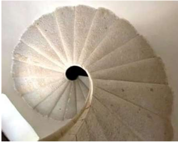
Scala elicoidale di accesso alla biblioteca.
